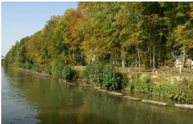
Stabilisation de berges et renaturation par génie écologique à Neuville-sur-Oise (95) © Manuel Pruvost-Bouvattier,
